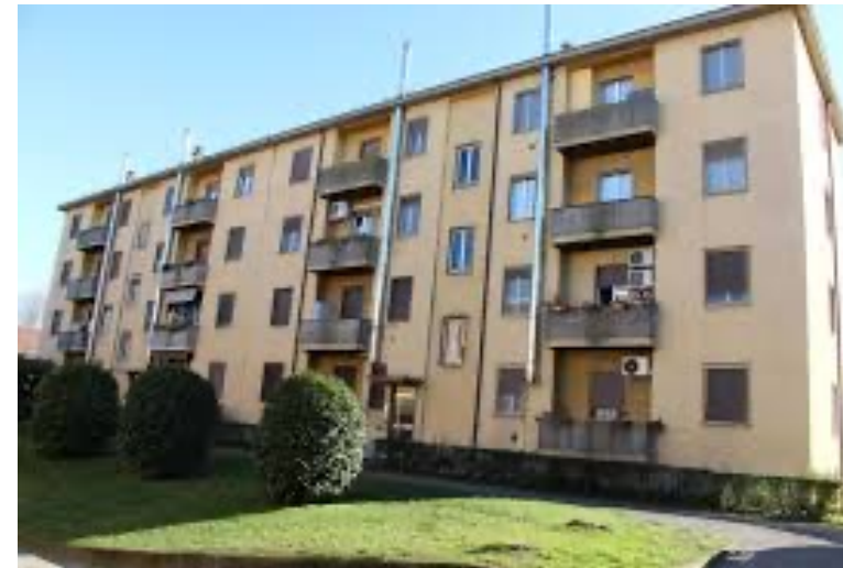
Edifici condominiali esistenti
