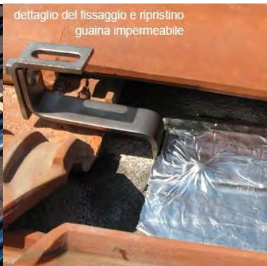
dettaglio della staffa inox installata
