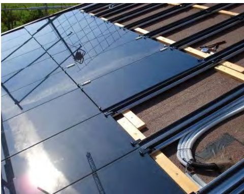
dettaglio del fissaggio e ripristino guaina impermeabile
